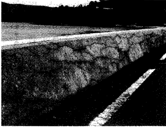
写真1 護岸パラペット部コンクリートのアルカリ骨材反応によるひび割れ発生状況
